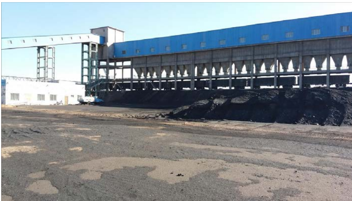
图 1 项目现场输煤皮带及筒仓
