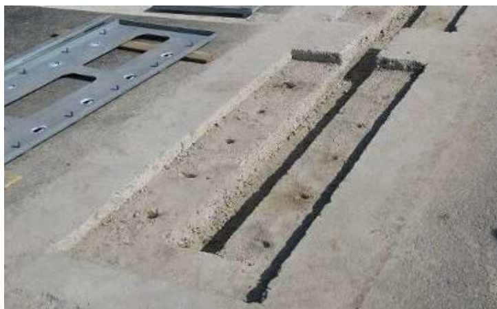
图4 弯板式开挖的基础坑示意图
