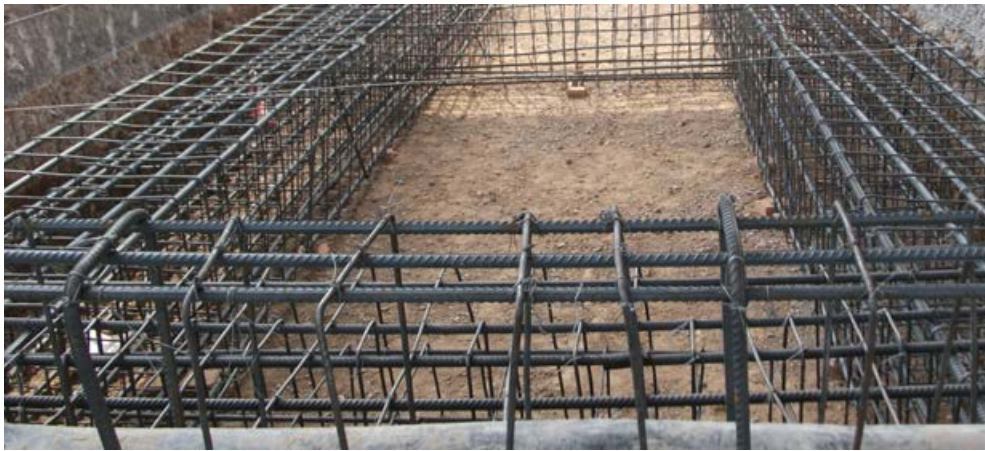
图 2 整车式基础结构示意图
