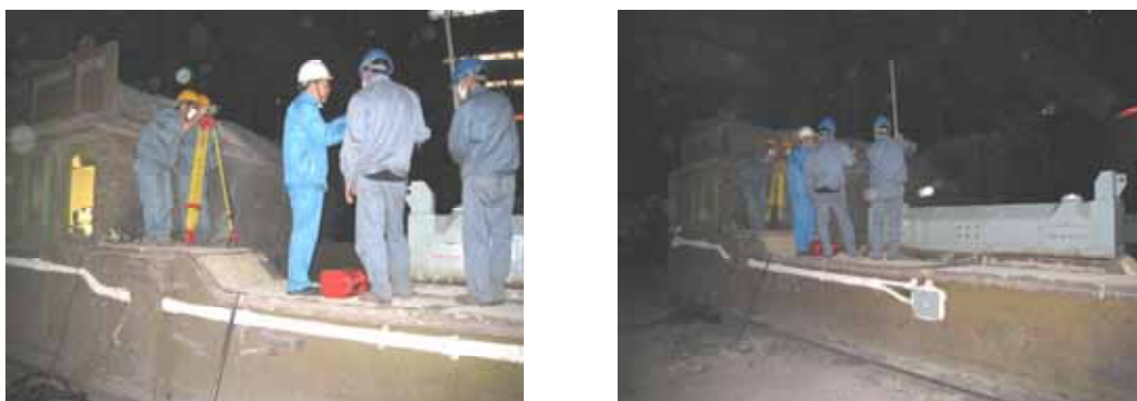
图 4 HSB-A-450t 大型转炉出钢车称量装置安装现场
