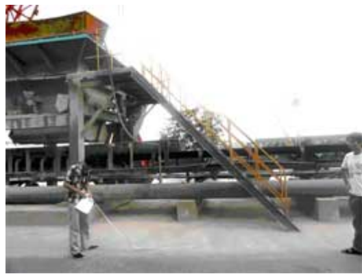
2、主料仓（料斗）现场
