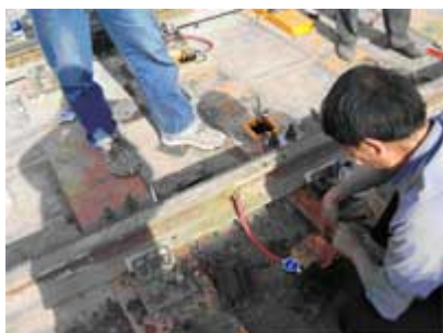
图 19 安装钱江剪力和板式传感器时的图片
