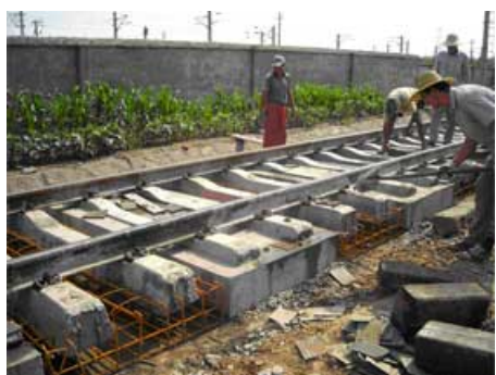
图 14 无基坑自动轨道衡整体道床施工图
