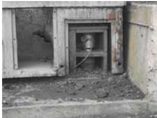
图 5 球顶式限位系统
