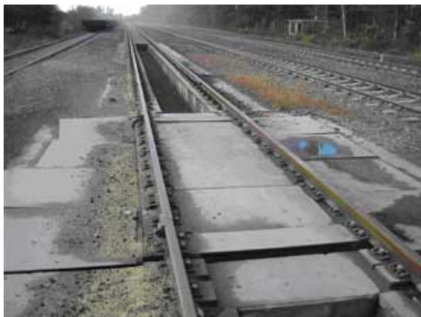
图 8 早期的自动轨道衡衡体和整体道床
